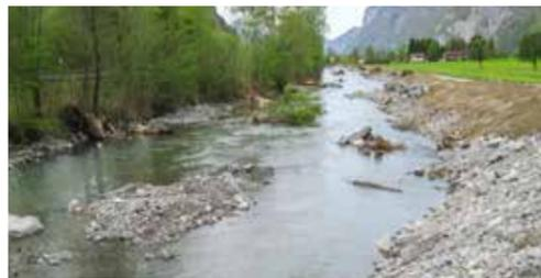
Aufweitung des Berschnerbachs mit Strukturelementen und variablen Breiten (Bauzustand).
